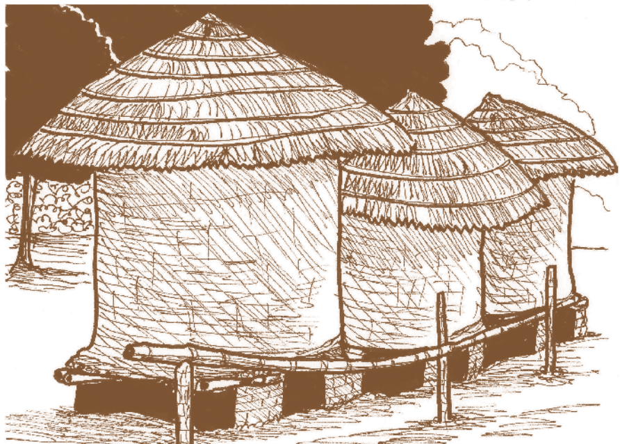
Greniers à parois en terre et toit de chaume
